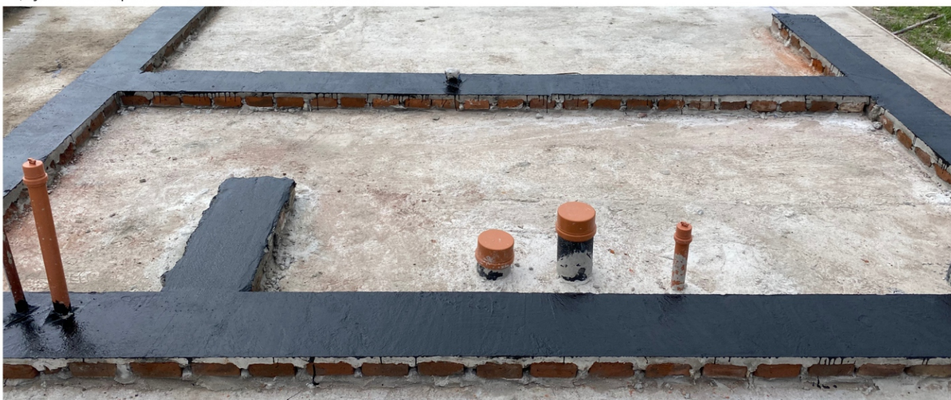
Impermeabilización del cordón elevador
