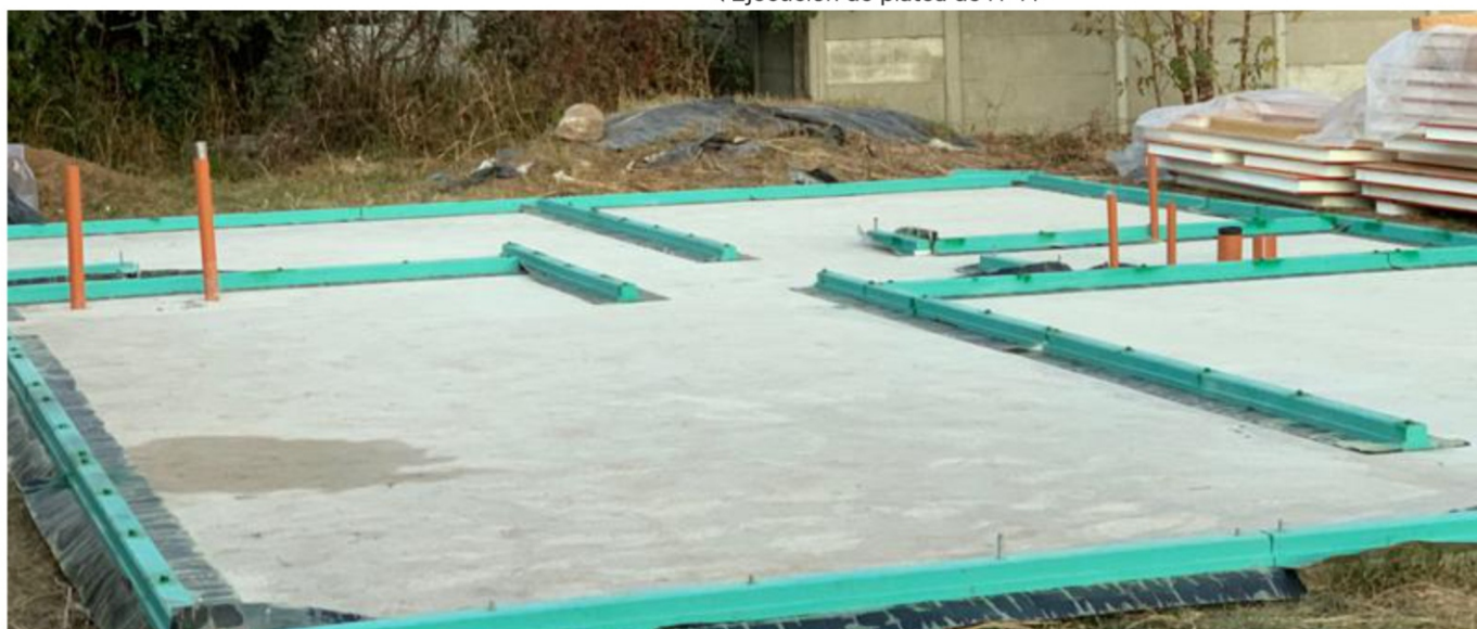
Instalación solera base
