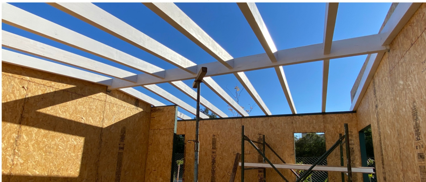
Colocación de tirantería de techo
