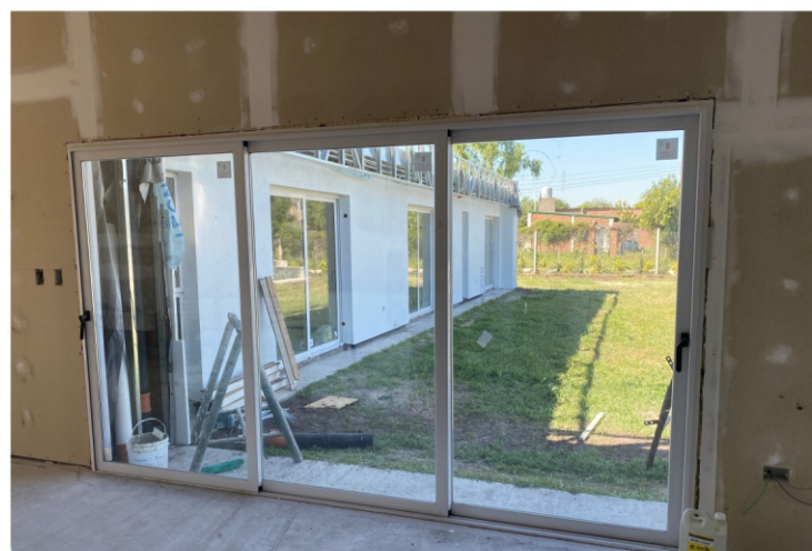
▼ Colocación de aberturas
