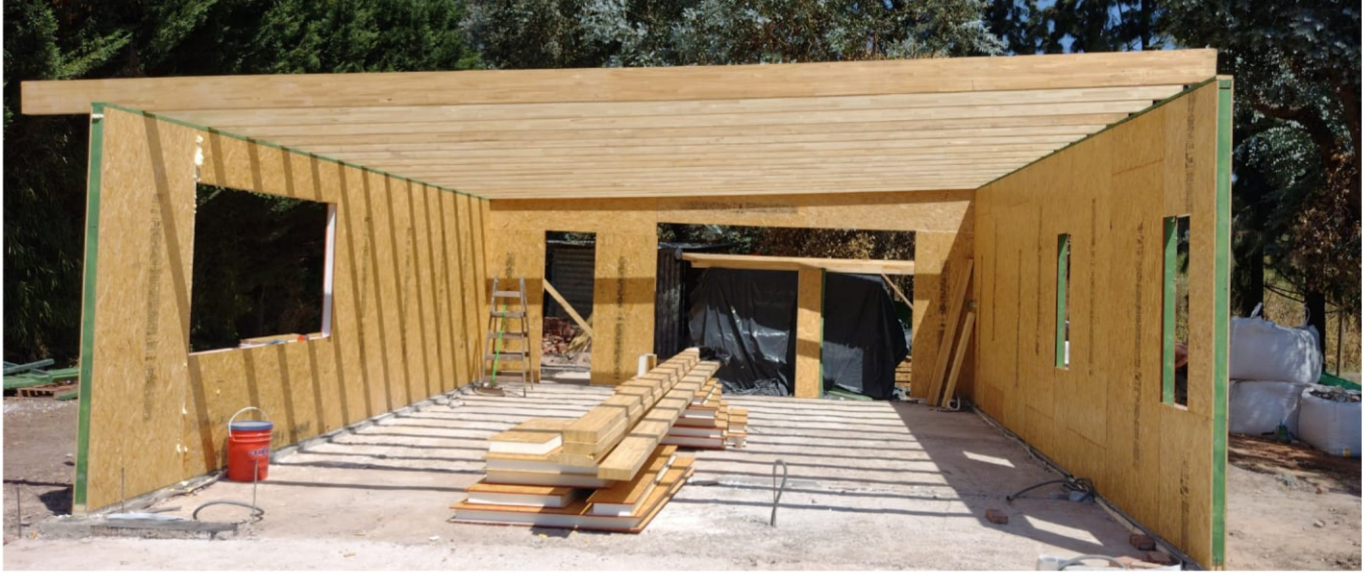
Colocación de estructura de techo
