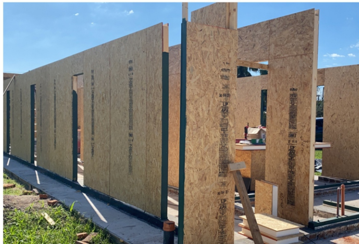
Instalación paneles de muro SIP70
