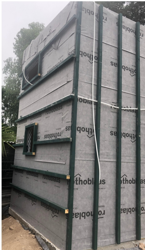
Instalación clavaderas exteriores
