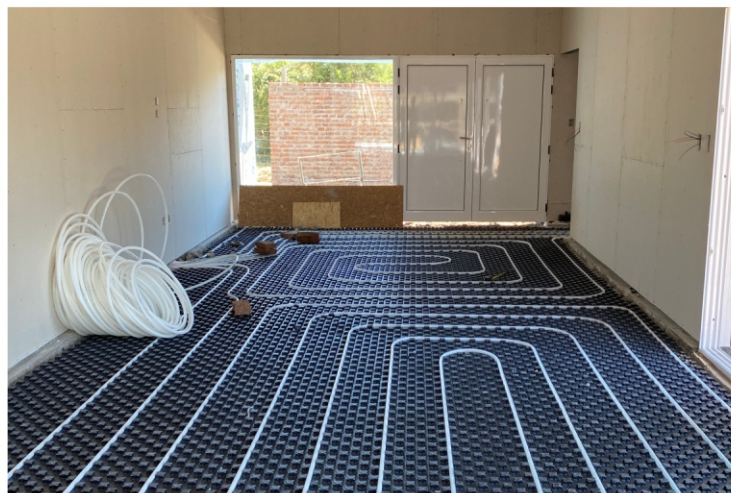
▼ Instalación losa radiante
