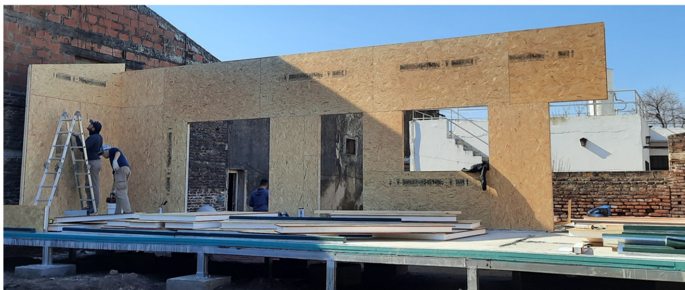
▼ Instalación de paneles de muro
