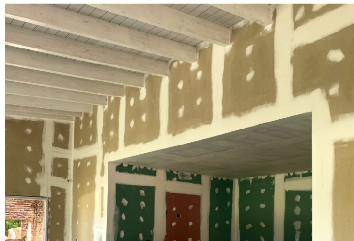
▼ Revestimiento interior placas de yeso
