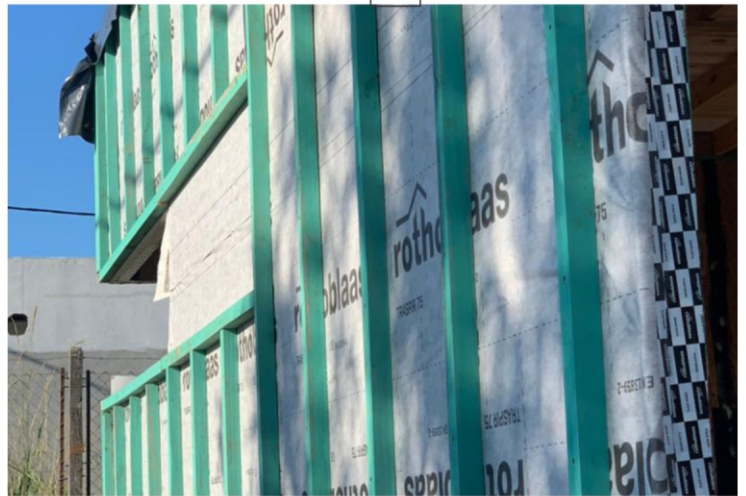
▼ Instalación clavaderas exterior
