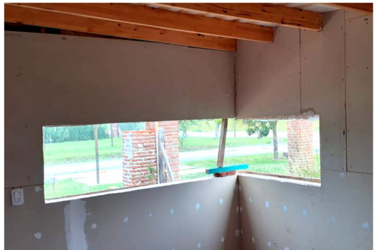
▼ Colocación de revestimiento interior
