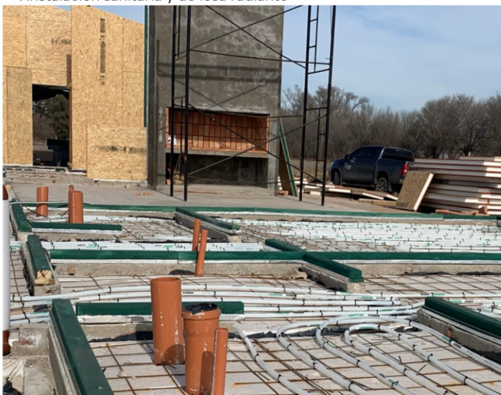
Instalación solera base y de losa radiante
