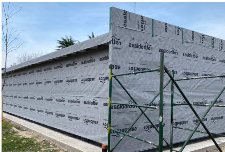
Colocación de membrana hidrófuga
