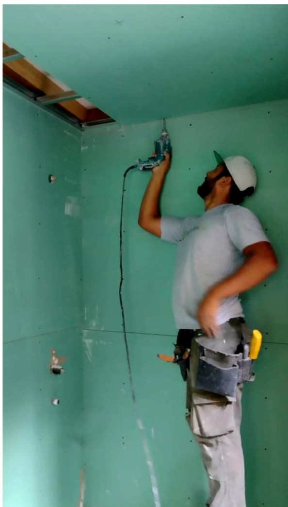
Instalación de placas de yeso RH
