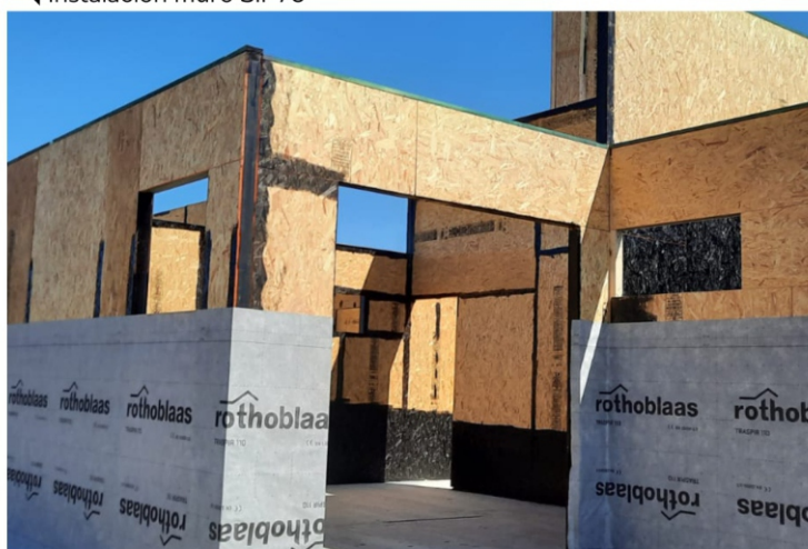
Instalación muro SIP70 y membrana hidrófuga
