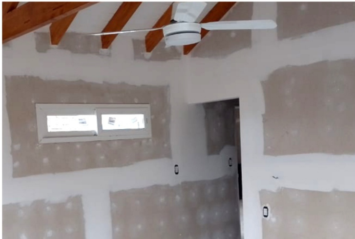
Revestimiento interior con placas de yeso
