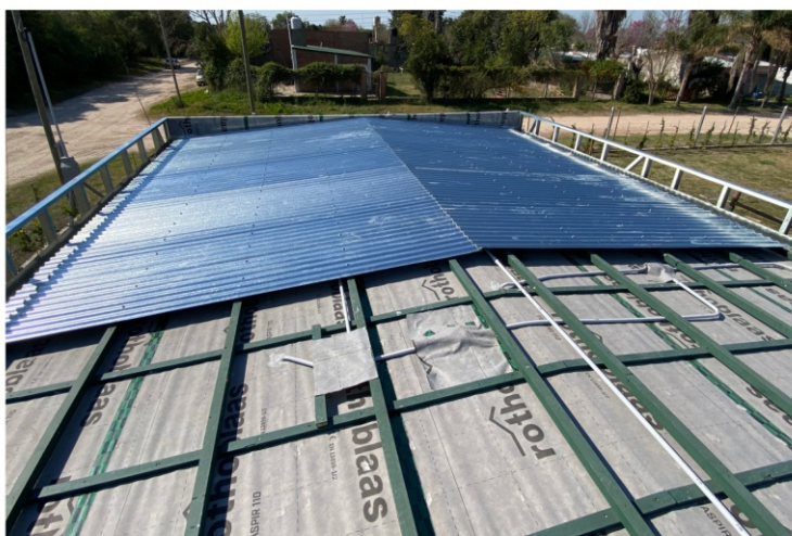
Colocación de terminación de cubierta - chapa
