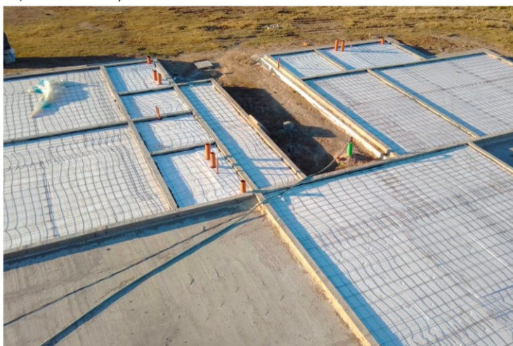
Instalación sanitaria y de losa radiante
