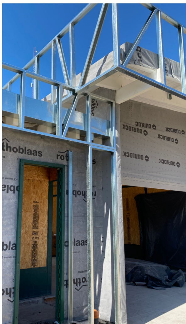
Instalación de pórticos de perfilería galvanizada
