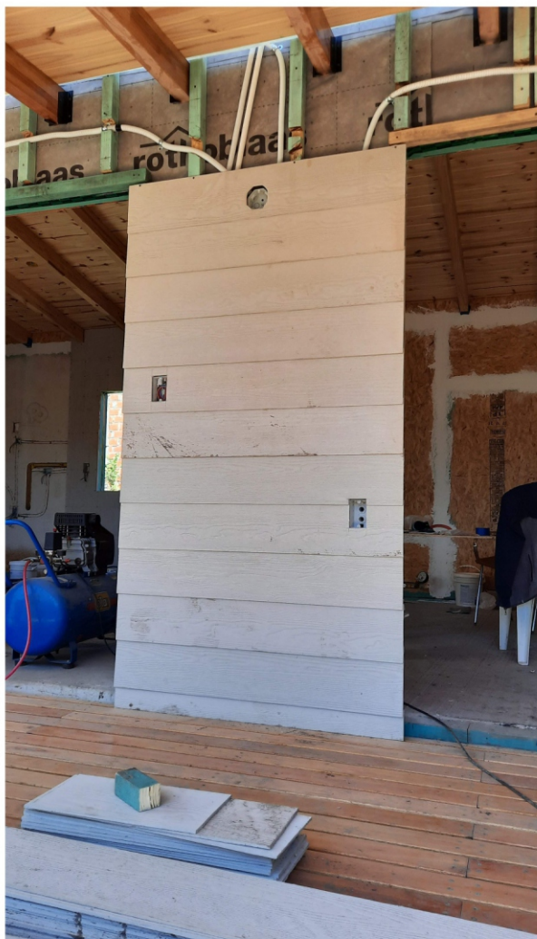
▼ Instalación de revestimiento exterior Siding
