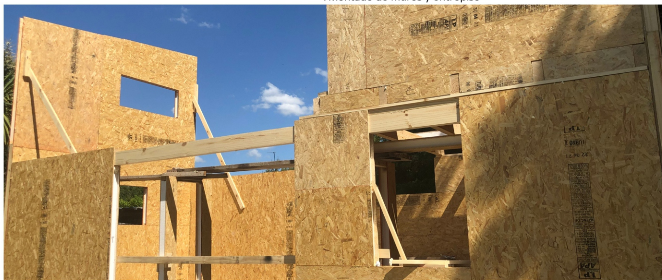
Montado de muro y entrepiso
