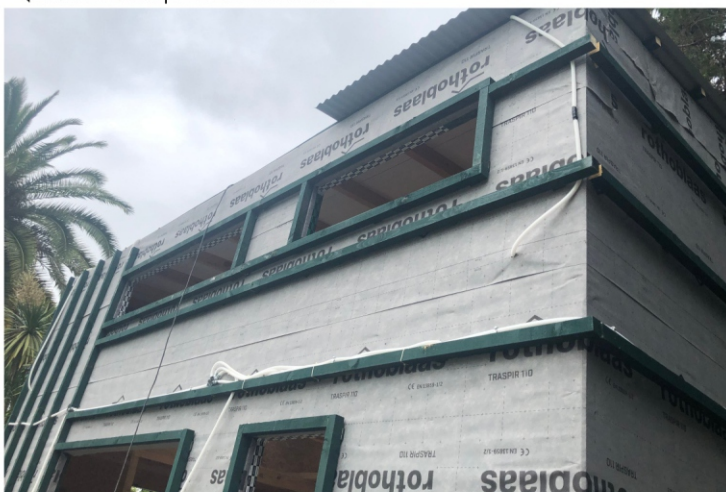
Instalación clavaderas exteriores
