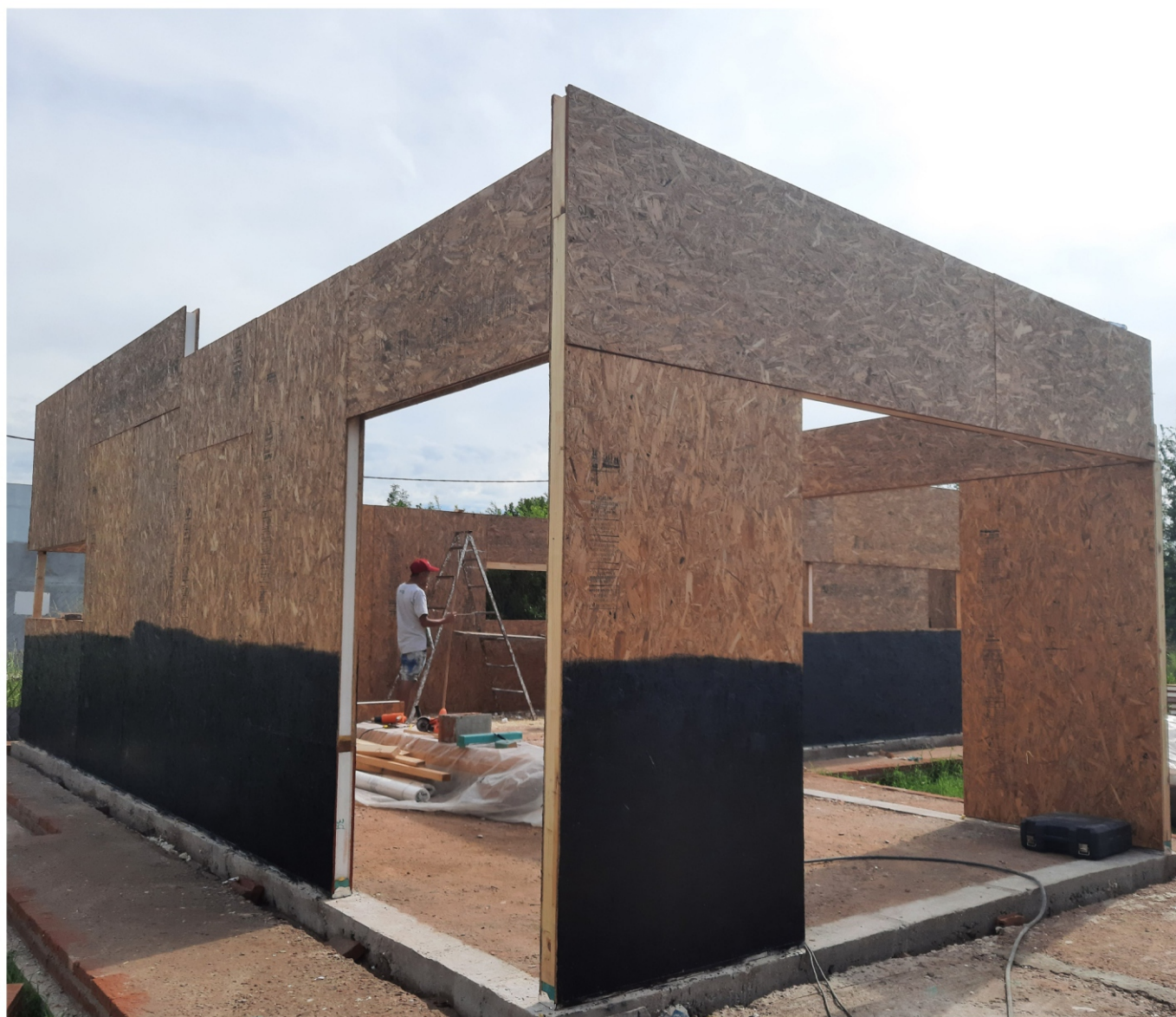
▼ Instalación paneles de muro
