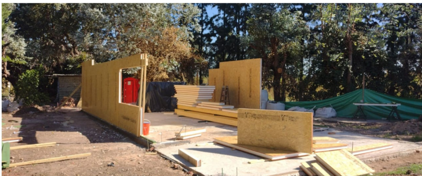
▼ Montado del kit de paneles
