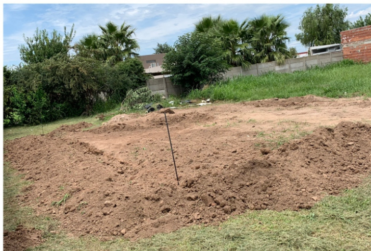
Movimiento de tierra y nivelación de terreno
