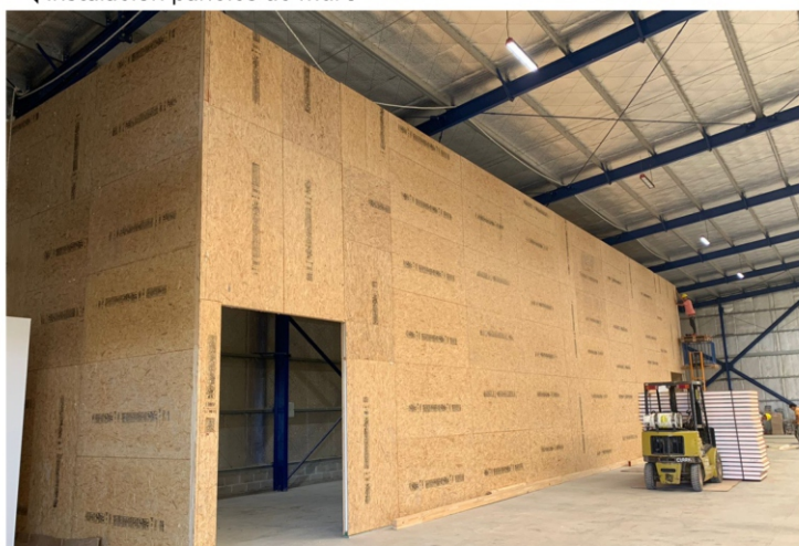
Instalación paneles de muro
