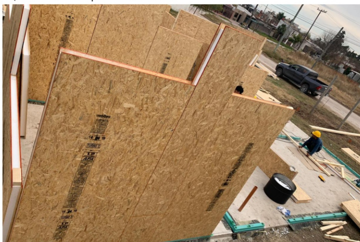
Colocación de peneles de muro
