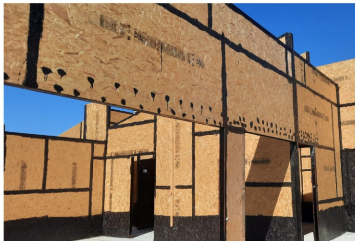
Instalación muro SIP70
