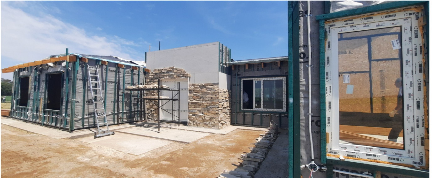
Colocación de revestimientos exteriores, aberturas, cubierta e instalación eléctrica
