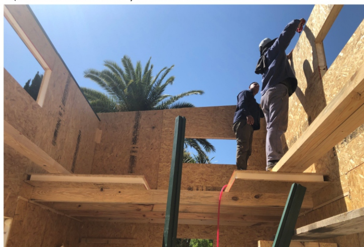
Montado de muros y entrepiso
