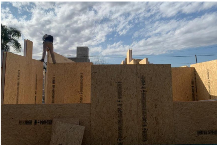
Colocación de peneles de muro
