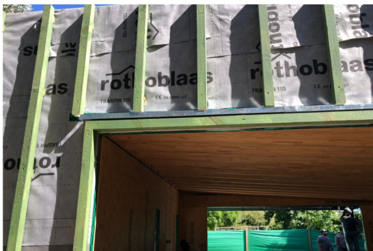
Colocación de clavaderas exteriores
