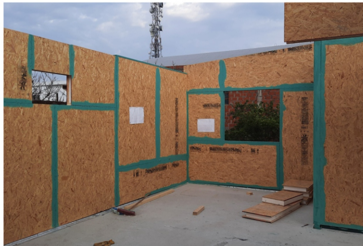
Instalación de paneles de muro
