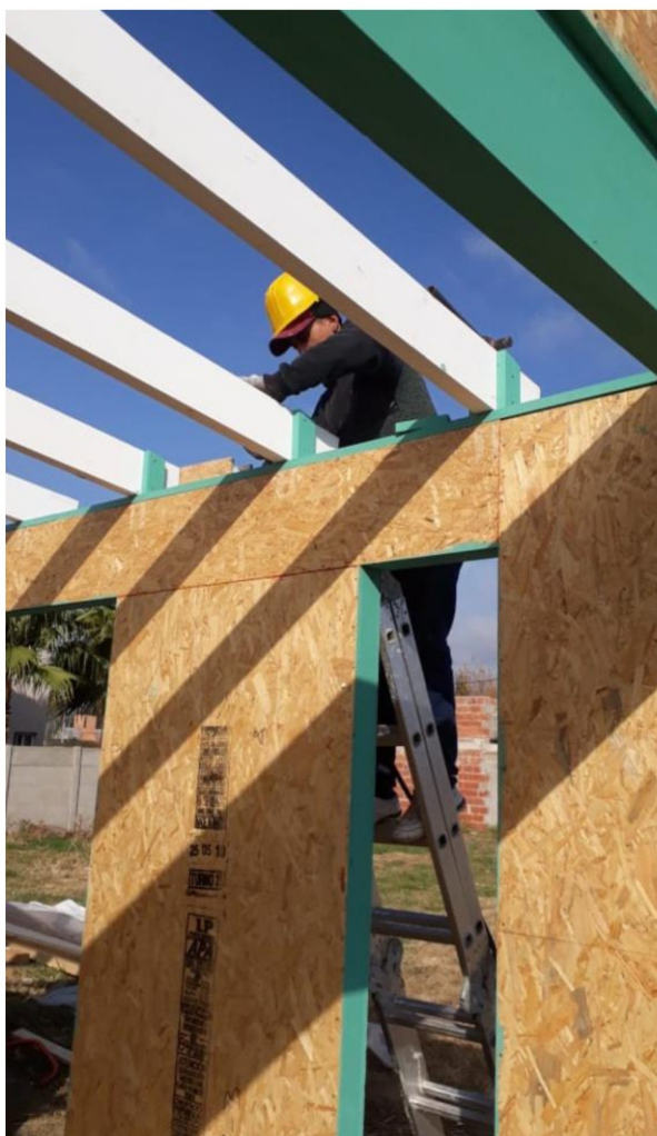
Instalación de enrase y tirantera de techo
