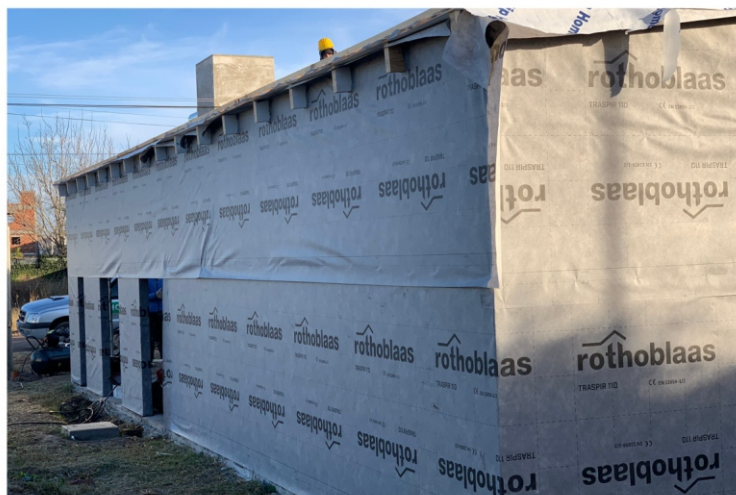
Colocación de membrana hidrófuga
