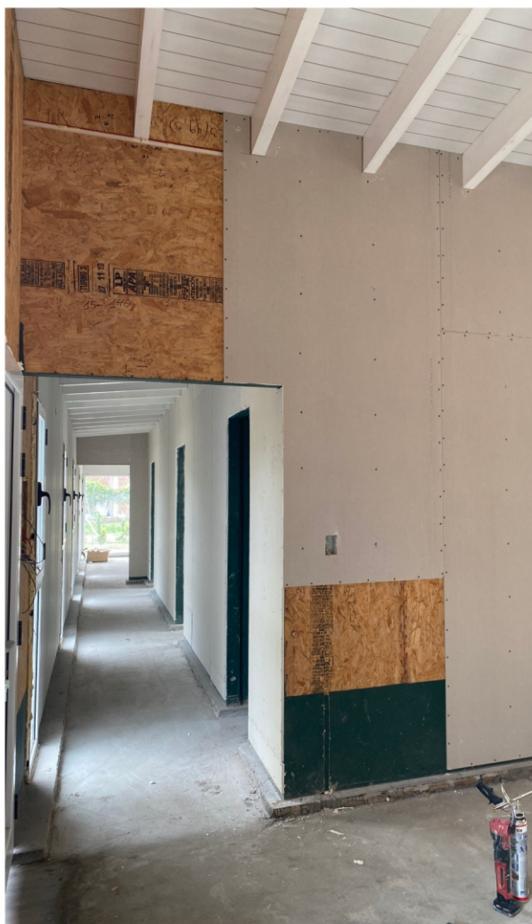
▼ Revestimiento interior placas de yeso
