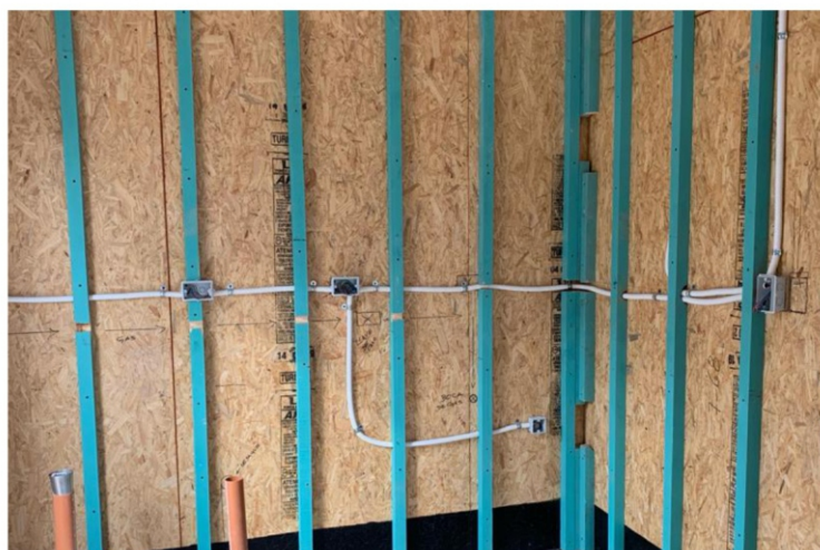
Colocación de clavaderas interiores e instalación eléctrica
