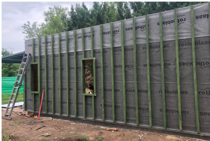
Colocación de clavaderas exteriores
