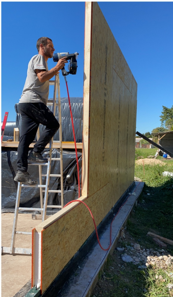
Instalación paneles de muro SIP70
