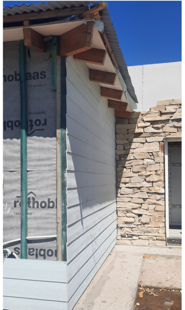
Detalle exterior de revestimiento siding y placas de fibrocemento con piedra
