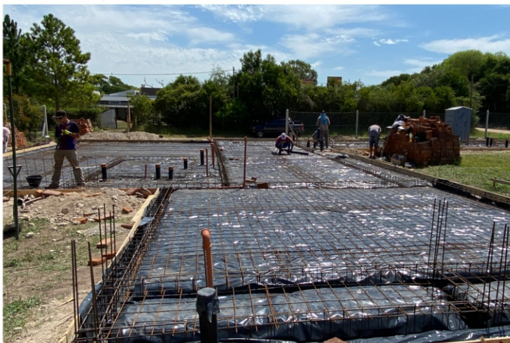
Ejecución de platea de H° A° e instalación sanitaria
