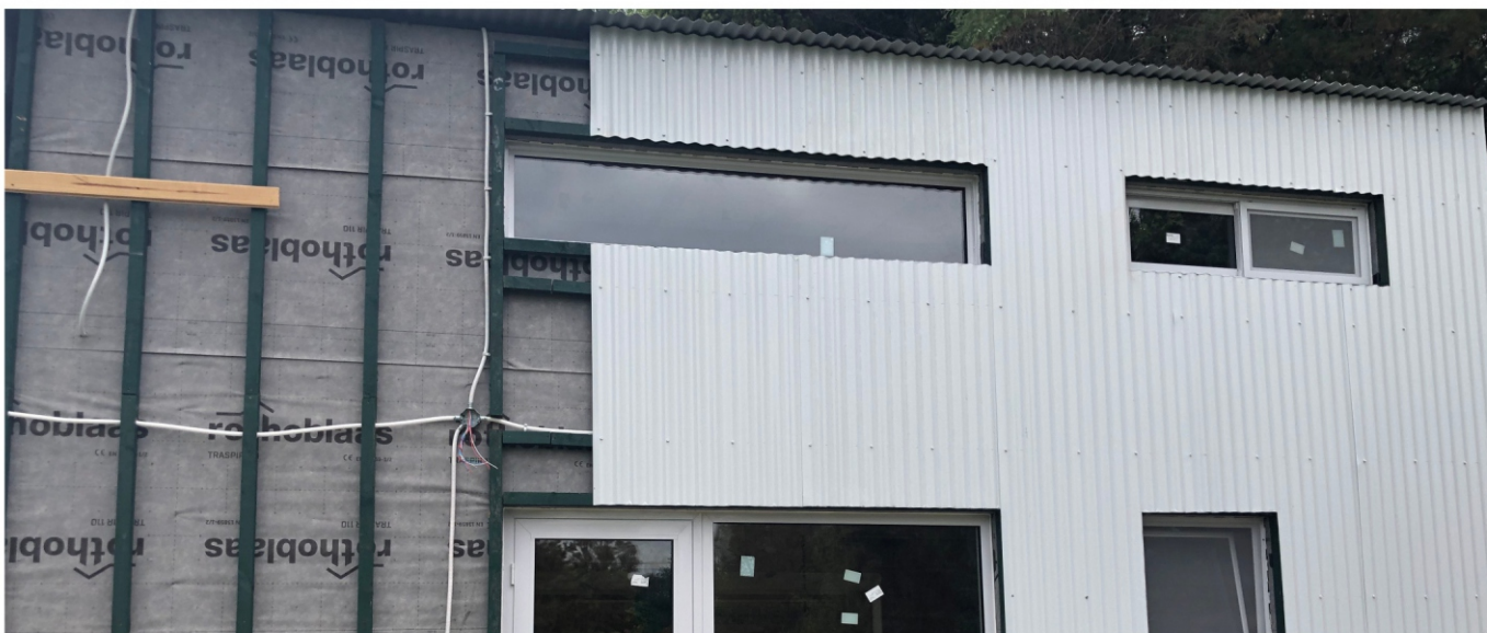
Colocación revestimiento exterior
