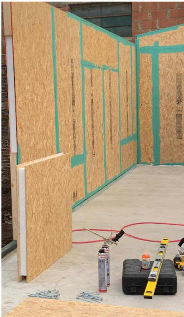
Instalación de paneles de muro
