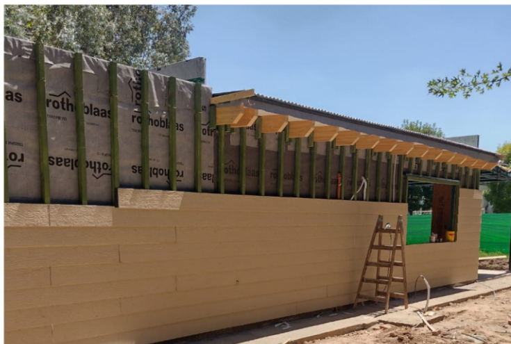
Montado del revestimiento exterior Siding
