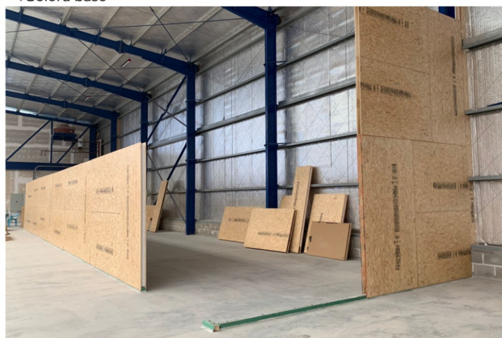
▼ Colocación de paneles de muro
