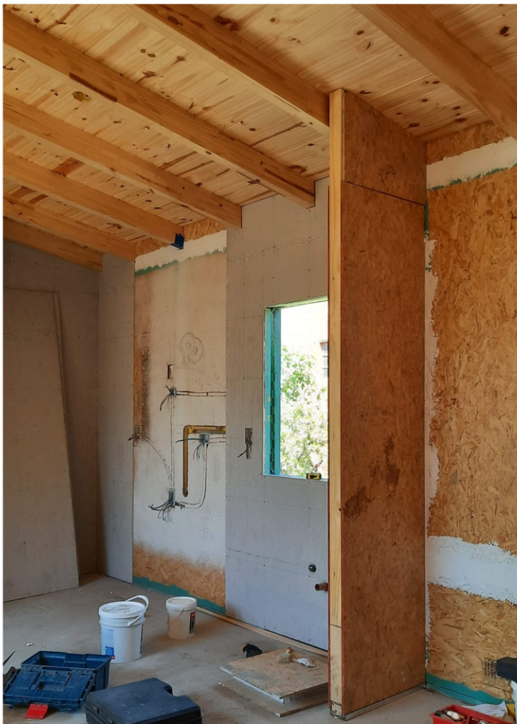
▼ Instalación revestimiento interior
