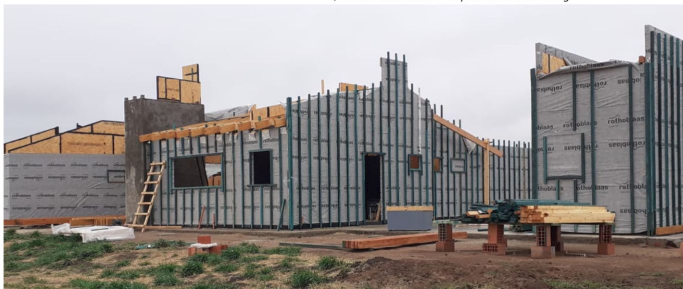
Proceso de envoltivo hidrófugo y clavadoras exteriores
