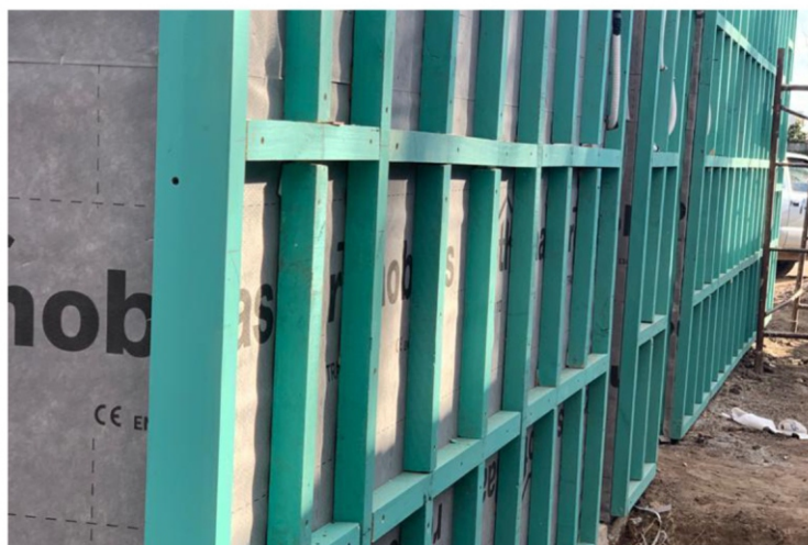
Colocación de clavaderas exteriores
