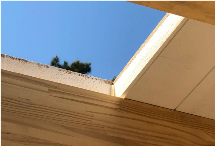
Montado de peneles de techo SIP45 ranurado
