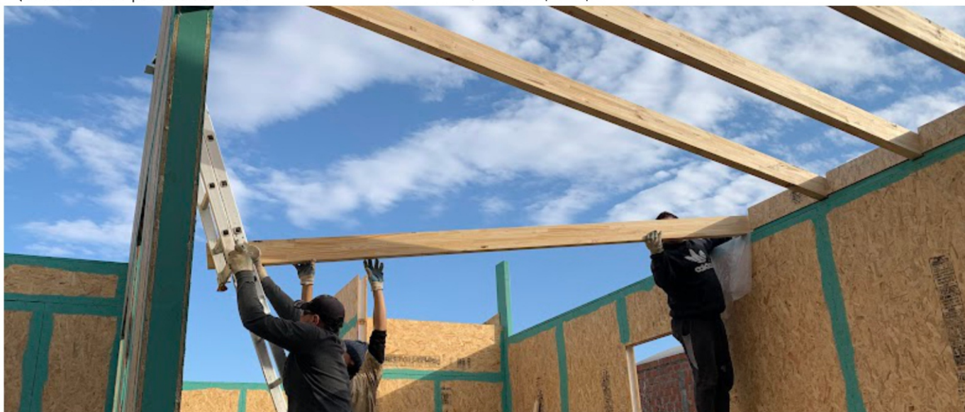
Colocación de estructura de techo
