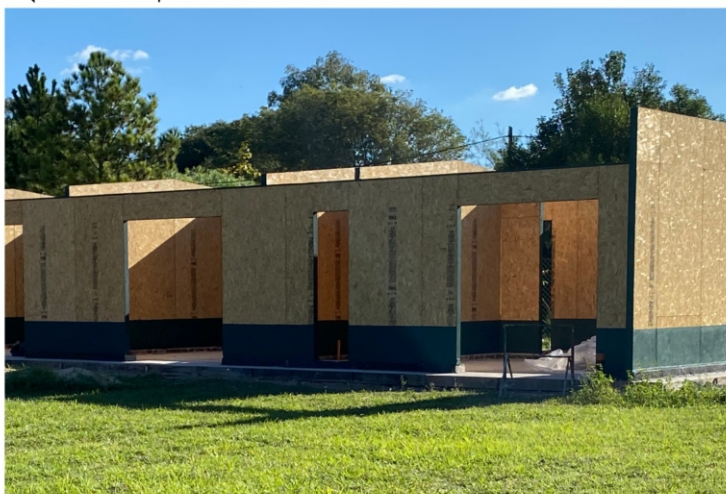
Impermeabilización de muros con membrana líquida a base de goma
