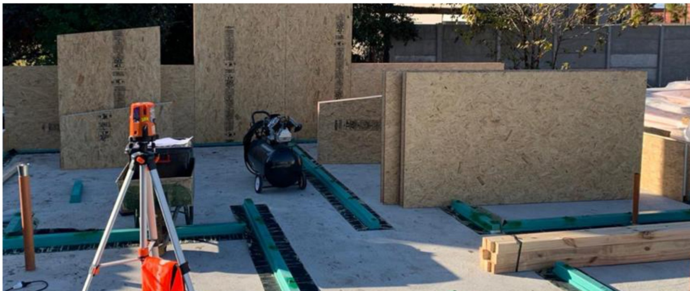
Colocación de peneles de muro
