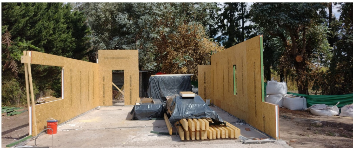
▼ Montado del kit de paneles
